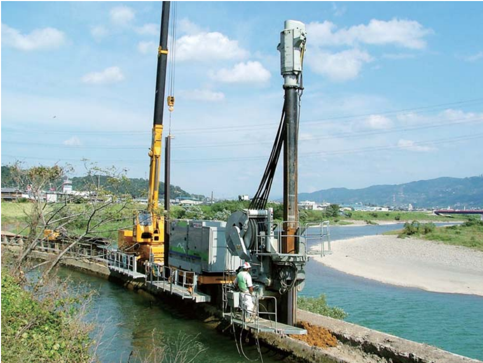
硬質地盤クリア工法による水路改修工事
